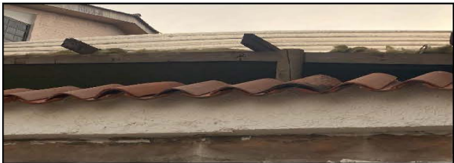
Fotos No.3 y 4 Material de freskasa entre techo y tejas en paredilla lateral del establecimiento TROPIQUE FOOD CLUB S.A.S
